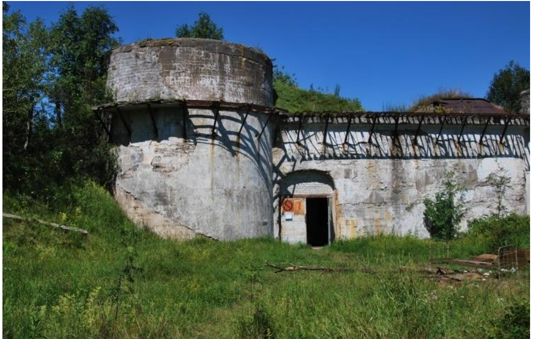
Рисунок 2.8 Помещение прожекторной станции
