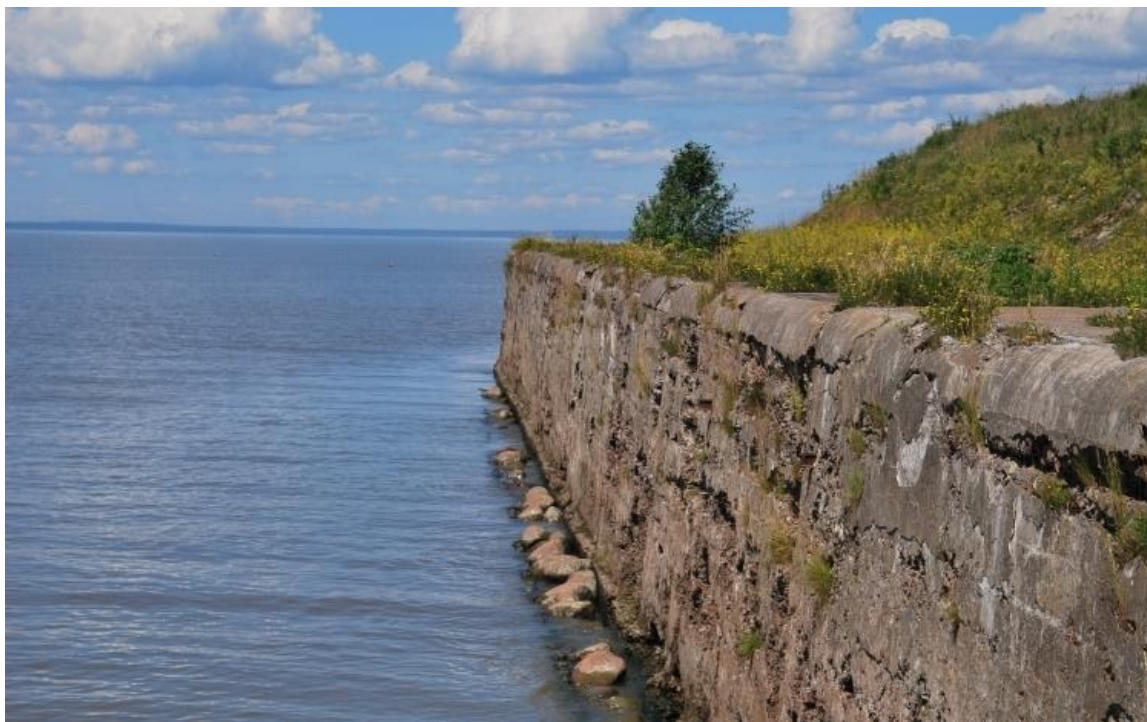
Рисунок 2.10 Бетонная стена эскарпа форта
