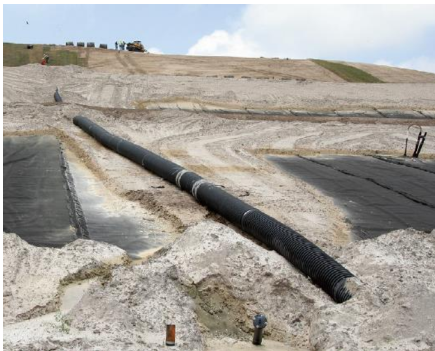
Рисунок 2.7 Барьерный изоляционный слой в процессе конструкции [15].
