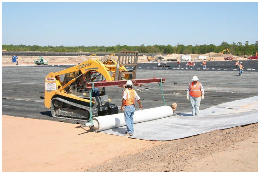
Рисунок 2.6 Строительство современного полигона для ТБО, прокладка изоляционного водонепроницаемого материала и системы для сбора фильтрата [15].
