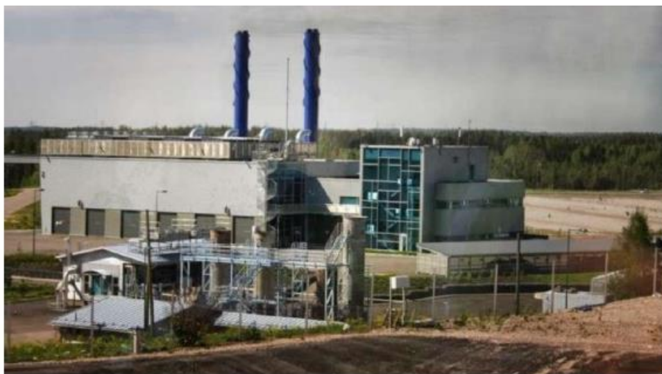
Рисунок 8. Установка по выработке электроэнергии и биогаза, собираемого на полигоне Ammassuola, Хельсинки, Финляндия (Алексеев А.А, 2014).
