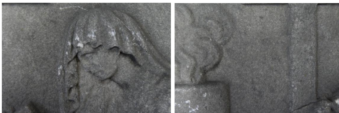
Рис.2. Грязевые наслоения, колонии темноокрашенных грибов на поверхности мрамора.
