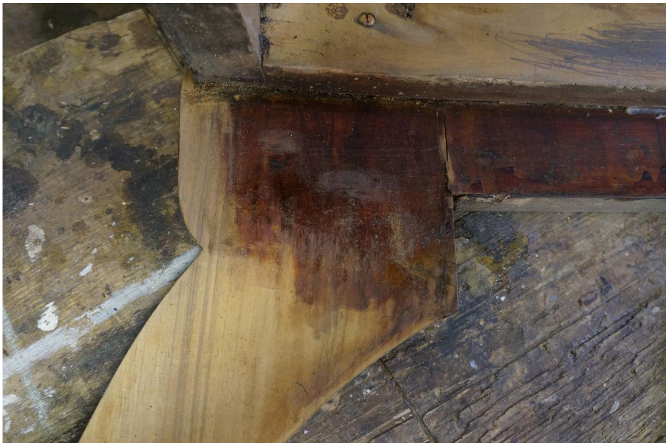
Фото №37. Проведение пробных расчисток на внутренней части левой боковой рамы.
