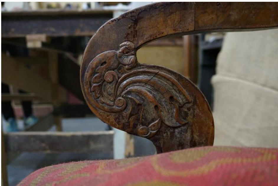
Рис.13. Локотник. Сохранившаяся накладная резьба. Отделочный слой деструктирован
