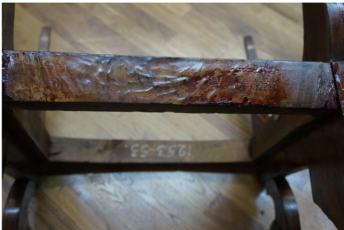
Фото №34. Задняя царга. Отслоение облицовки от основы.
