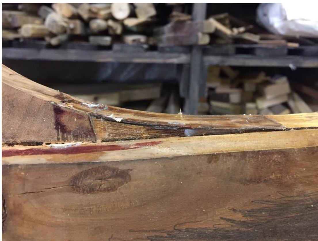
Фото№54. Внутренняя часть левой боковой рамы. Подготовка под вставку.
