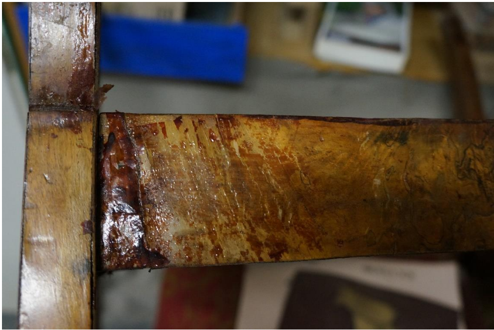
Рис.22. Задняя царга. Наслоения лаков и загрязнений.
