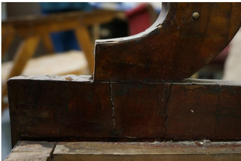
Рис. 20. Левая боковая рама. Разрывы древесины(фрагмент)
