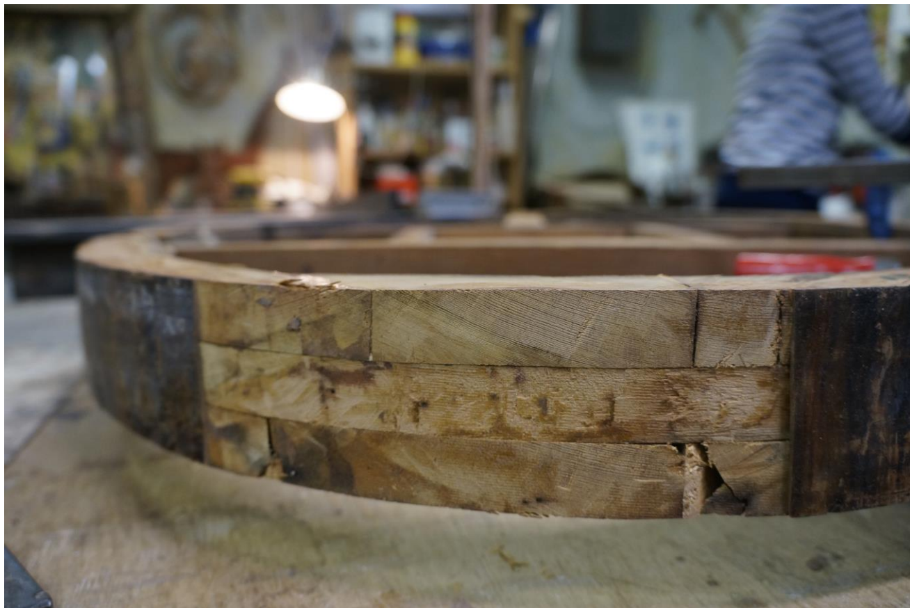
Фото №26. Трещины на царговом поясе
