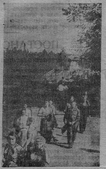
После трудовой смены строителей ждет заслуженный отдых.
