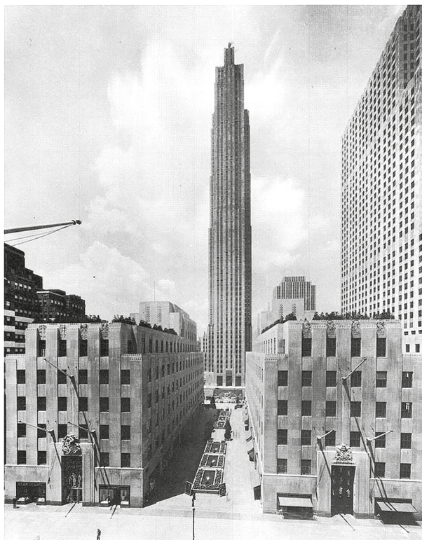
Строительство Рокфеллер-центра в Нью-Йорке. Фото 1935 г.
