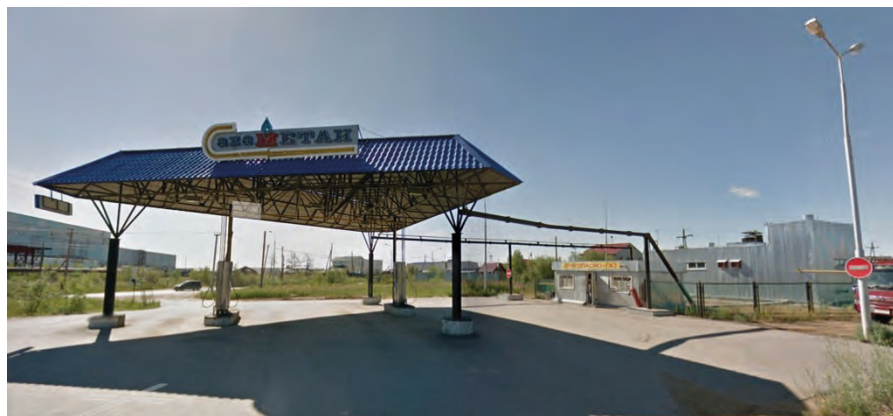
Рис. 7. Внешний вид АГНКС-1, Якутск
