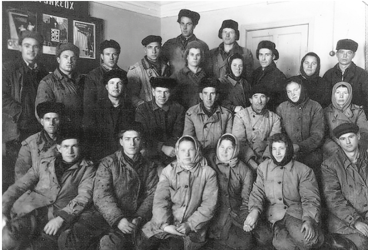
Рис. 5. Бригада строителей под руководством И. Ф. Андреева. Кстово, 1950-е гг. [Из коллекции Кстовского историко-краеведческого музея (ИКМ-326)]
