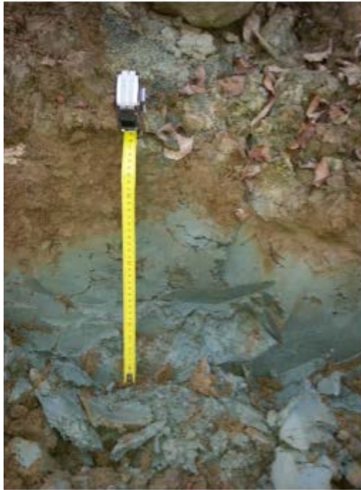
Рисунок 20. Фрагмент поверхности скольжения в шурфе.
