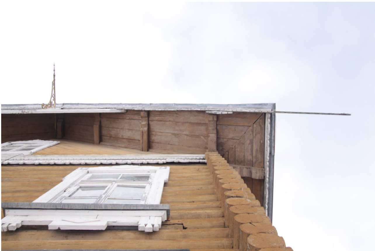
Рисунок 31. Северный фасад, свес кровли
