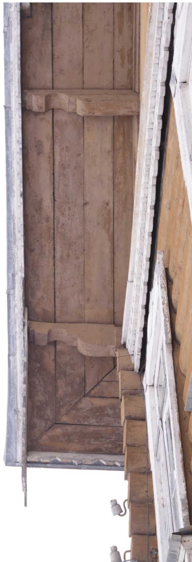
Рисунок 30. Северный фасад, свес кровли
