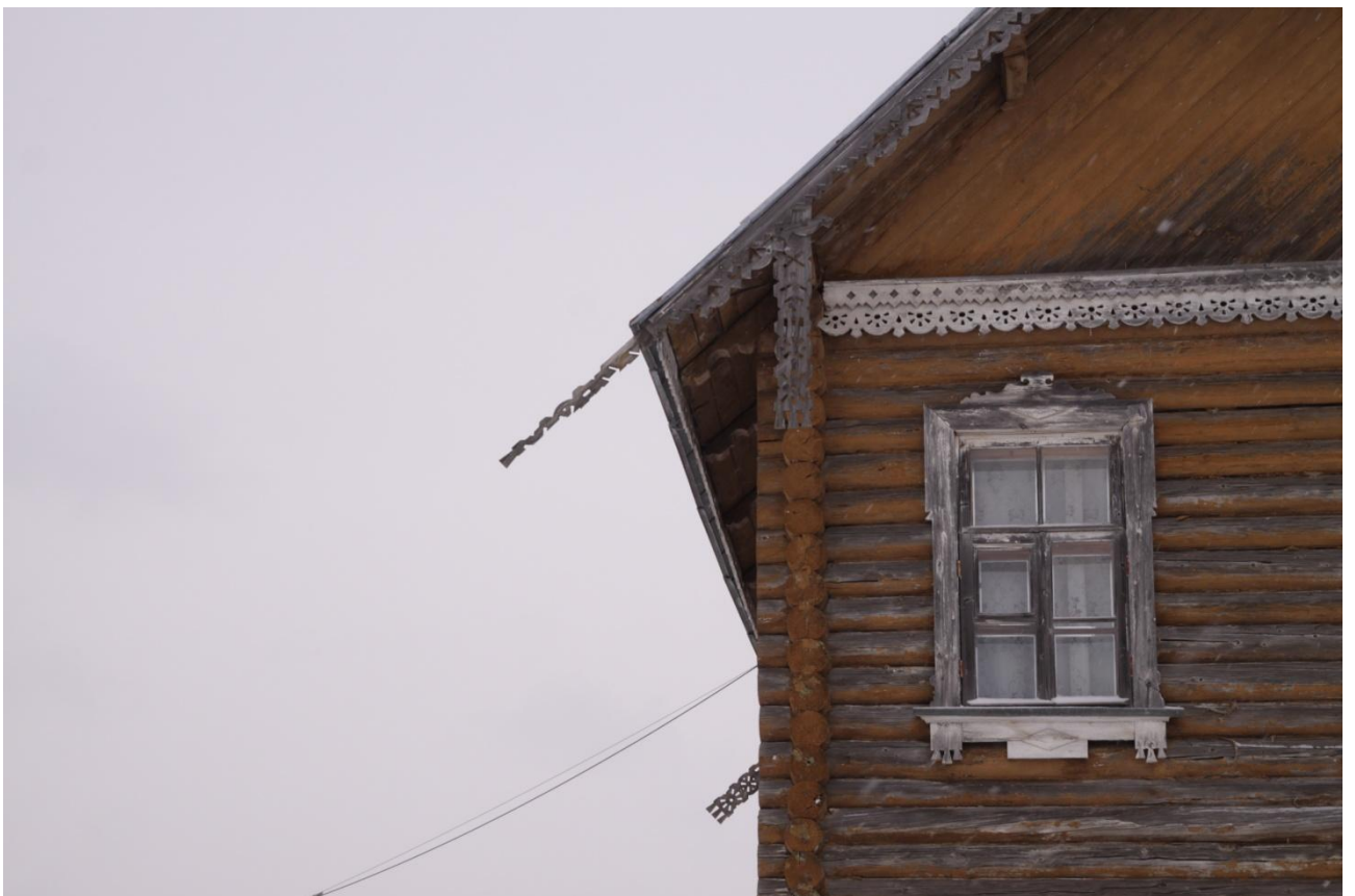
Рисунок 27. Южный фасад, фрагмент
