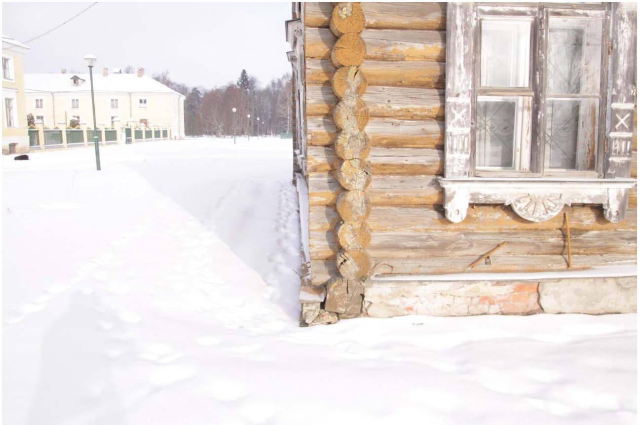
Рисунок 38. Южный фасад, фрагмент
