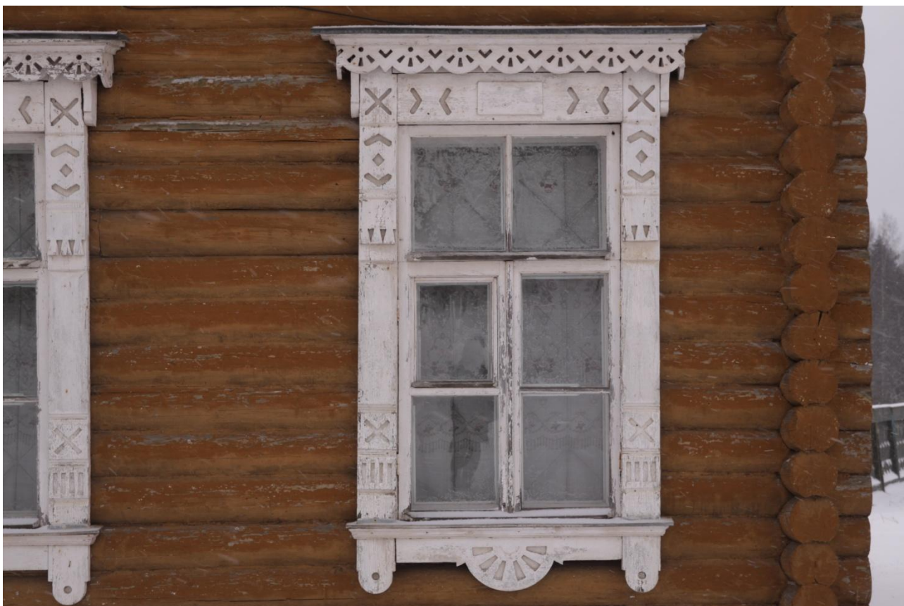
Рисунок 19. Северный фасад, наличник оконного проёма 1 этажа
