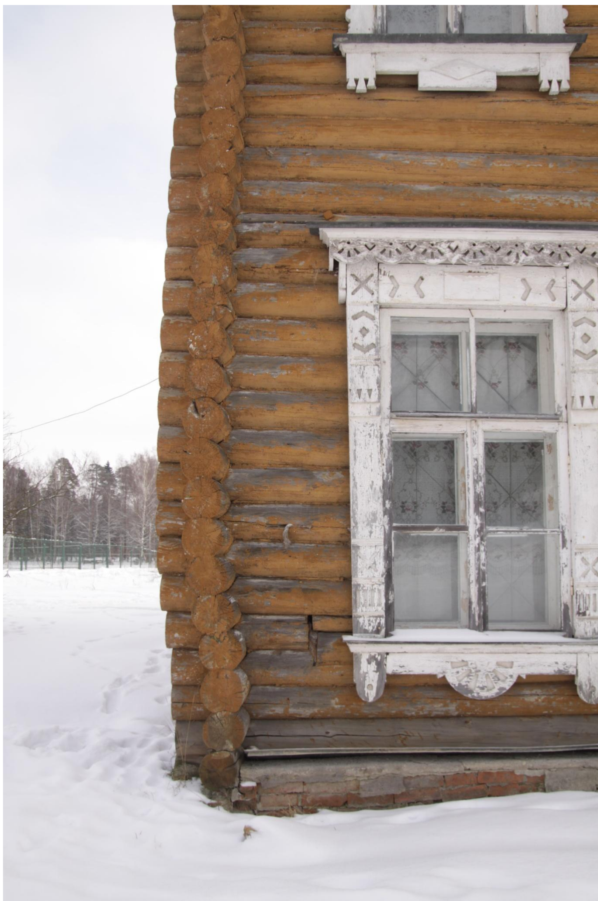
Рисунок 39. Западный фасад, фрагмент
