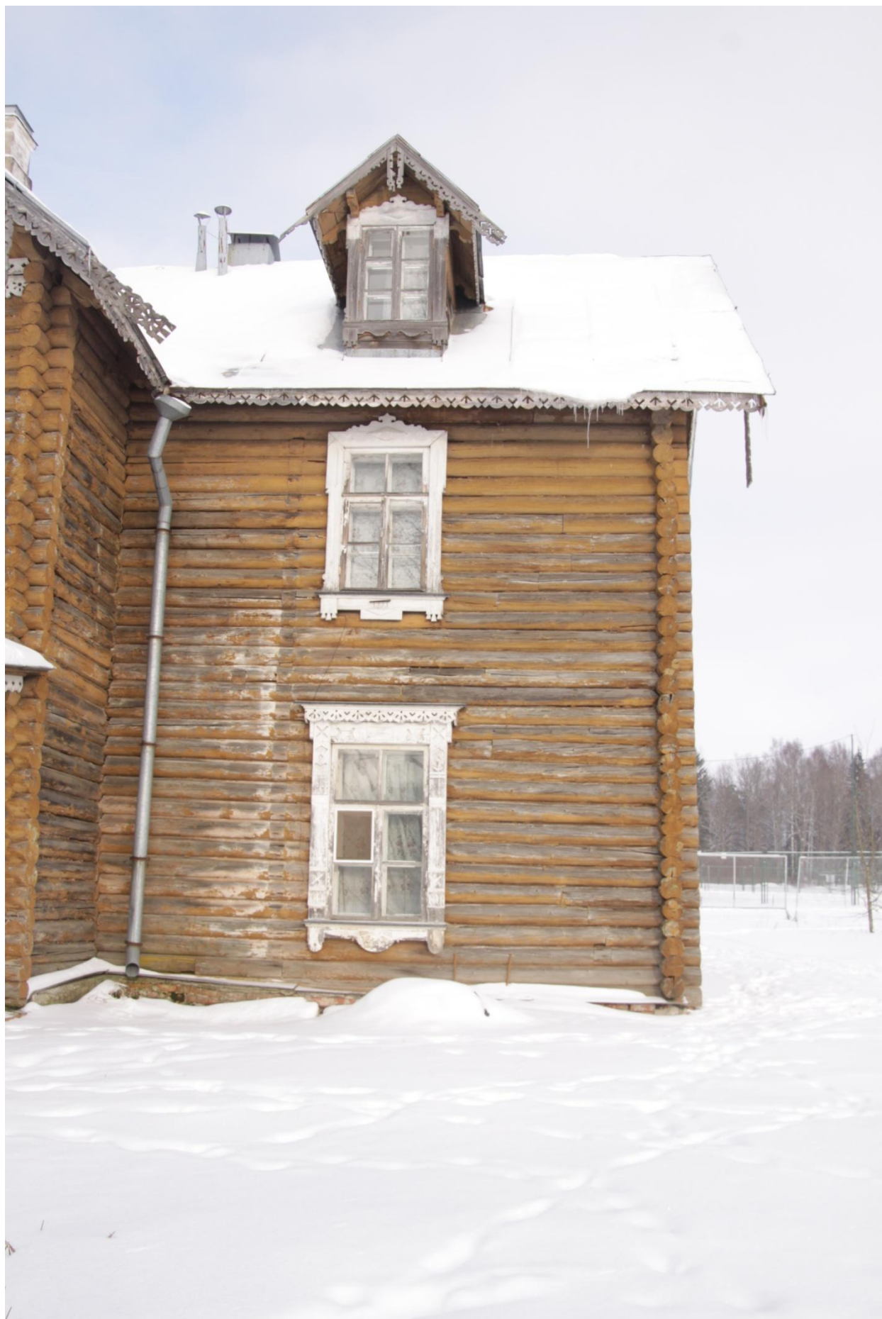
Рисунок 34. Южный фасад, фрагмент
