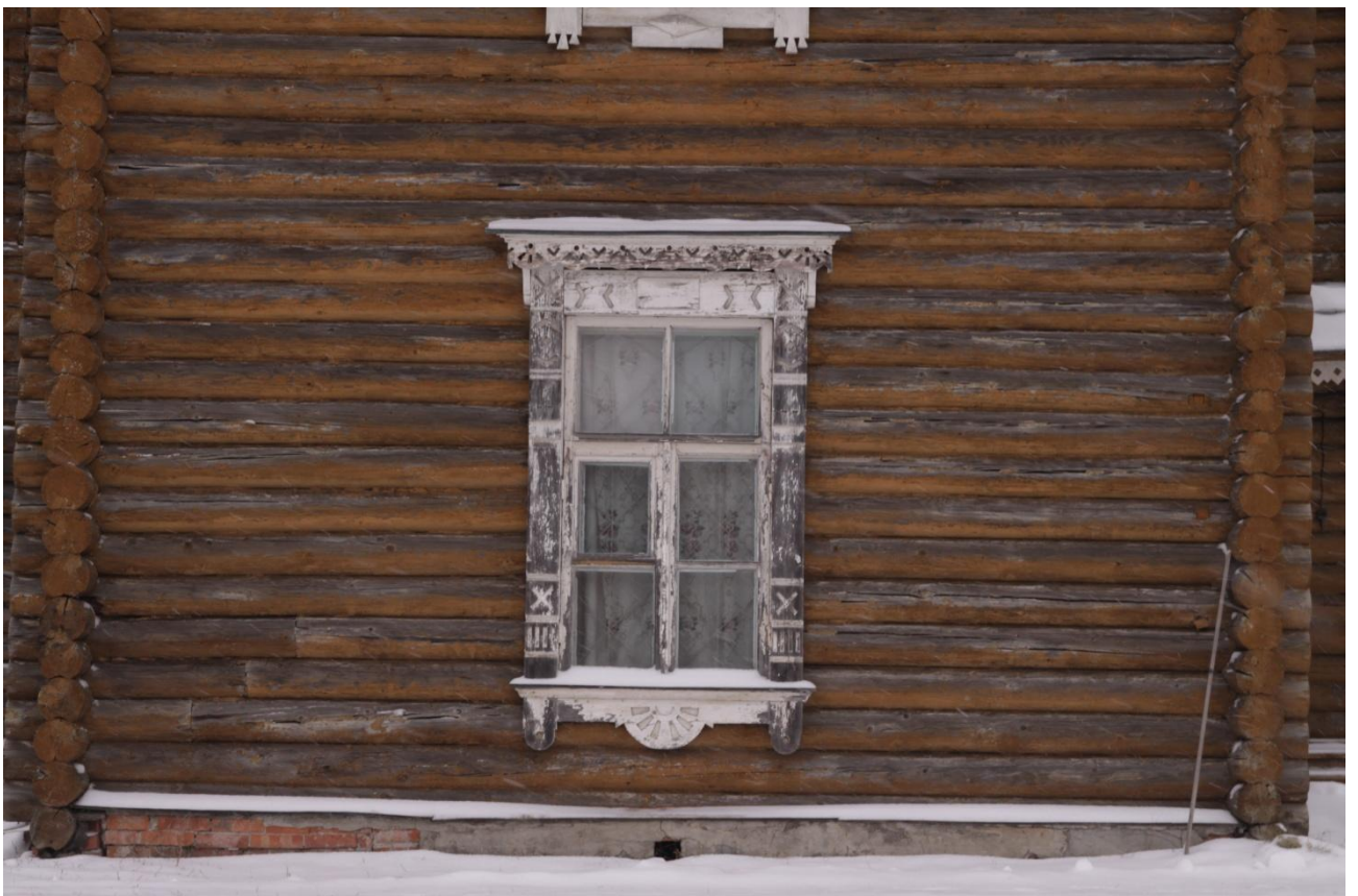
Рисунок 22. Восточный фасад, наличник оконного проёма 1 этажа
