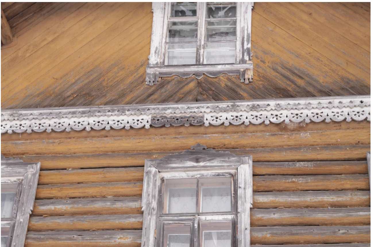
Рисунок 37. Южный фасад, фрагмент
