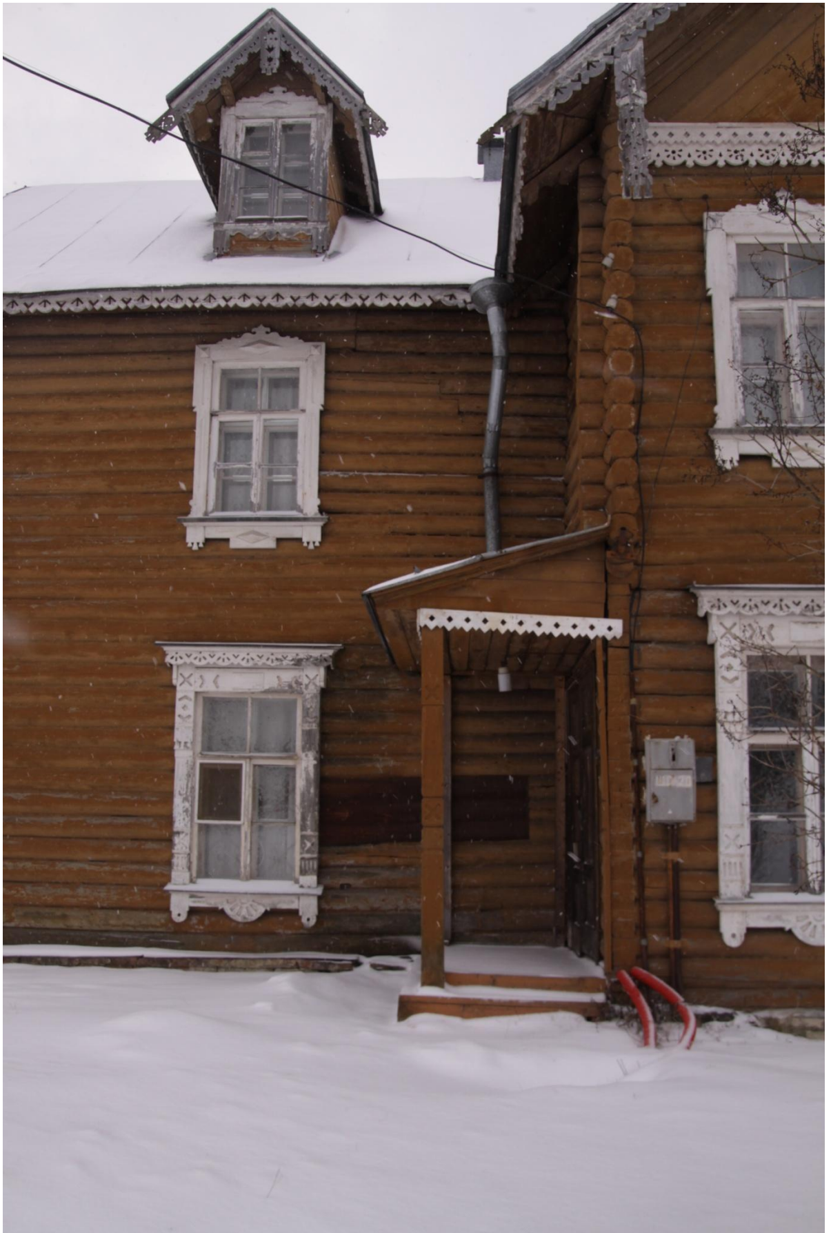
Рисунок 20. Северный фасад, фрагмент, входная группа
