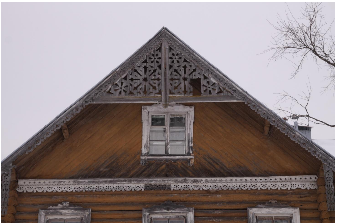
Рисунок 25. Южный фасад, фрагмент фронтона
