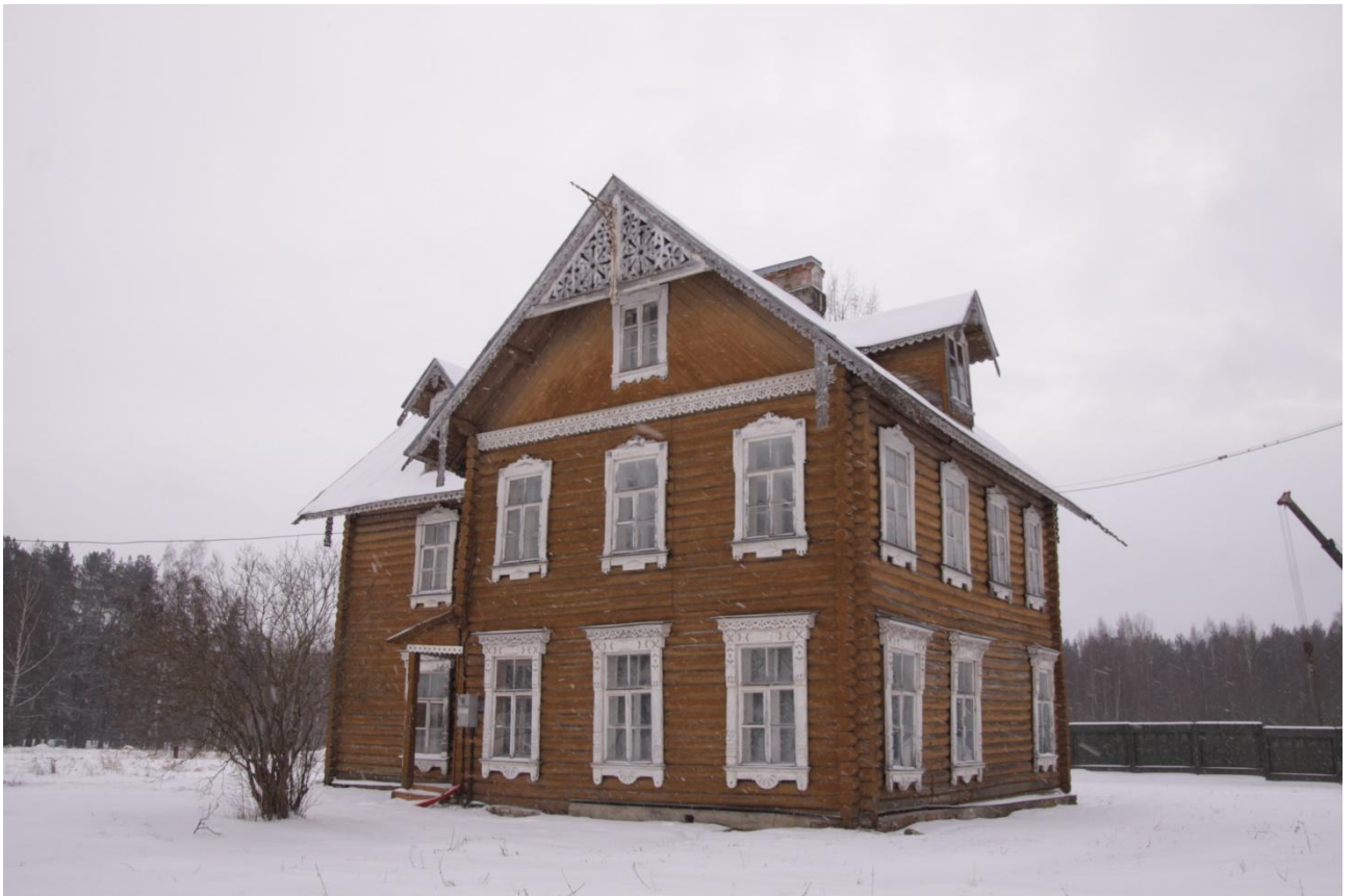
Рисунок 17. Вид с северо-запада
