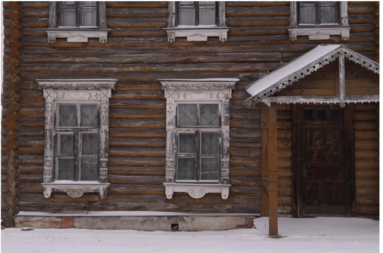
Рисунок 26. Южный фасад, фрагмент
