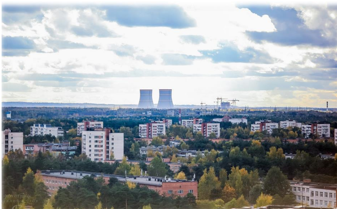
Рис. № 7 Общий вид на реакторы ЛАЭС в г. Сосновый Бор
